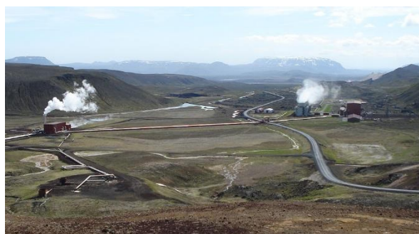
GEOTERMÁLNÍ ELEKTRÁRNA, KRAFLA
